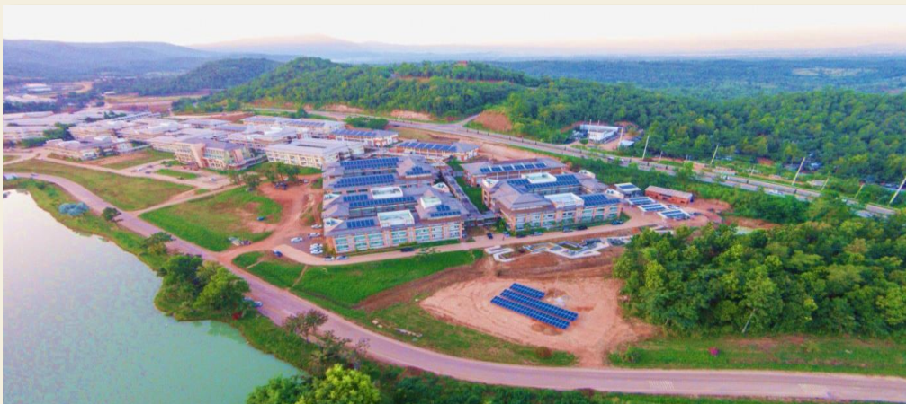
การติดตั้งเซลล์แสงอาทิตย์บริเวณอาคารกลุ่มวิทยาศาสตร์ทั้งแบบติดตั้งบนหลังคาและบนพื้นดิน
