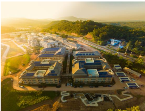
ระบบสมาร์ทกริด 500 kW
