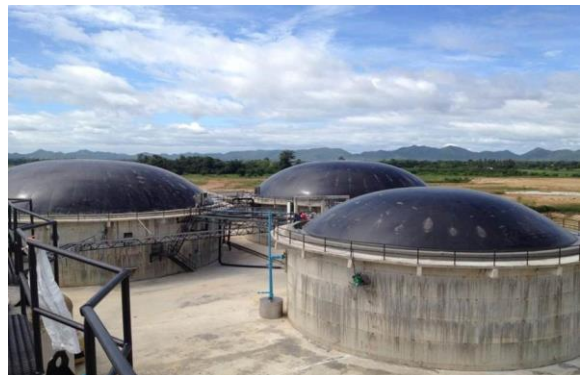
ภาพที่ 2 ถังหมักหญ้าเนเปียร์แบบไม่ใช้อากาศ (สถาบันวิจัยและพัฒนาพลังงานนครพิงค์, 2561)
